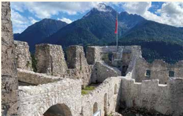
Kernburg mit Torhalle und Aussichtsplattform am Dürnitz
